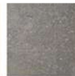
Estructura de baldosas y hormigón
